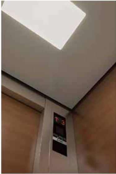
吊顶：涂装钢板（Y033），配乳白色树脂灯罩 照明：中央照明
